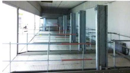
Obere Plattformen mit Fahrblechen aus Aluminium-Tränenblech und Spezialanfahrkeil zur Fahrzeugpositionierung.
